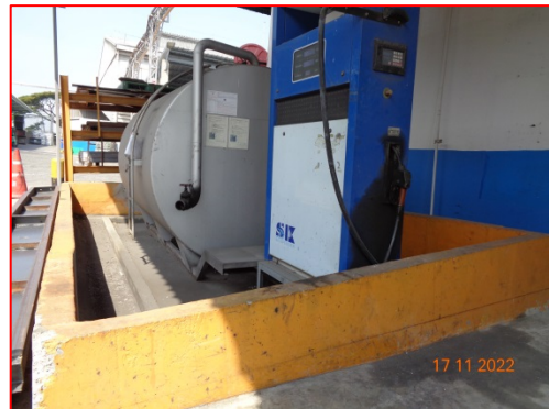
ภาพที่ 2.3-22 กำแพงล้อมรอบถังเก็บกัก น้ำมันดีเซล
