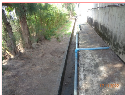
ภาพที่ 2.3-18 ท่อรวบรวมน้ำฝนปนเปื้อน บริเวณลานเก็บกองวัตถุติด
