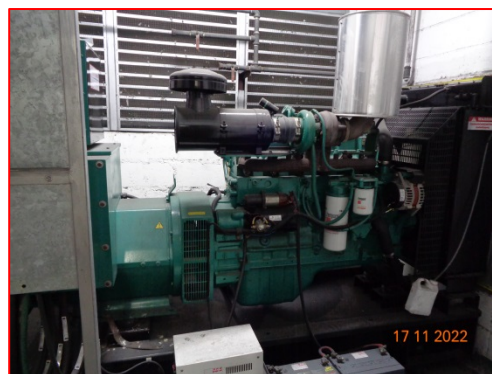
ภาพที่ 2.3-3 เครื่องกำเนิดไฟฟ้าสำรอง
